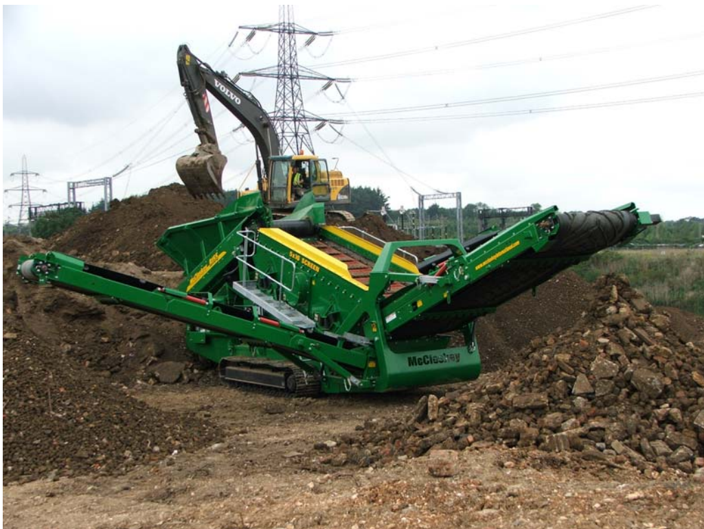
Использование грохота R155 на сортировке строительных отходов
